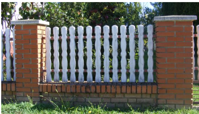
Áttört jellegű kerítés 2. - falazott kerítésoszloppal, faléces kerítésmezővel
