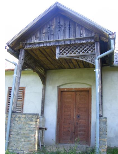
Présház eredeti faszervezetű kődisállás/előtettővel
